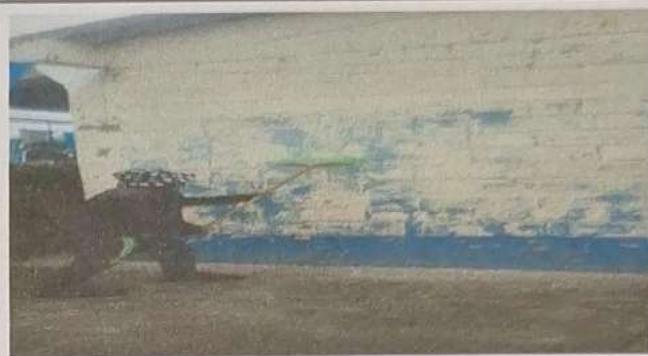
Foto 8: Pintada en muros exteriores e interiores
