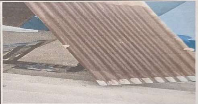
Foto 4: Desinstalación de lamina existente
