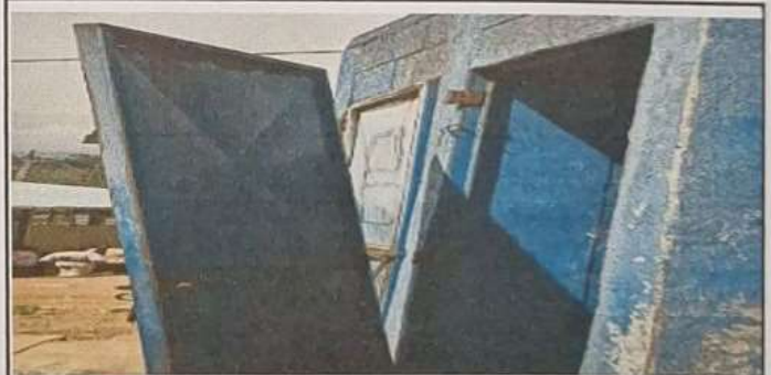
Foto 6: Cambio de puertas en servicios sanitarios
