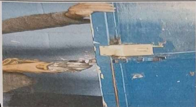
Foto 7: Cambio de chapas marca yale
