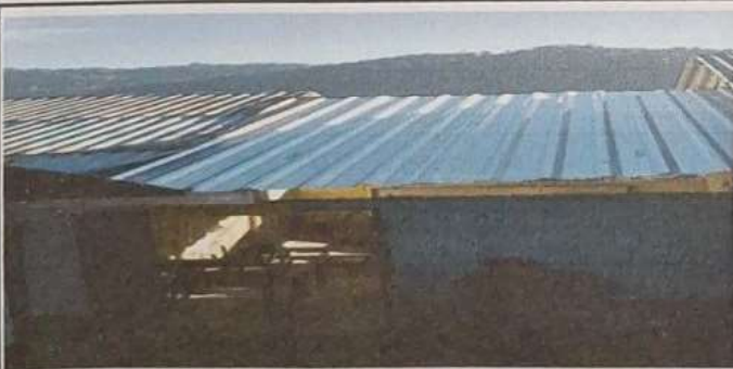
Foto 5: Colocacion de lamina troquelada
