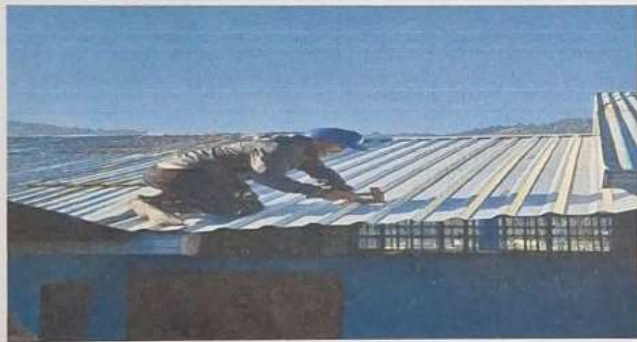
Foto 3: Cambio de elementos de fijación
